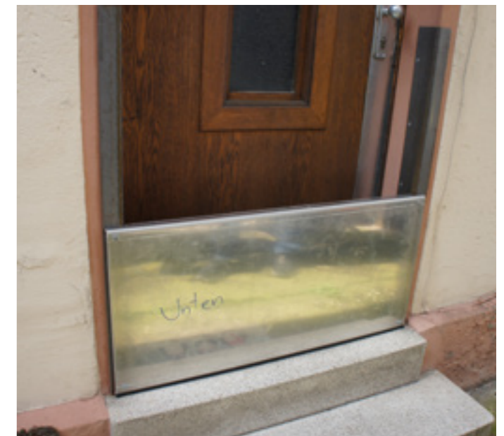
Eine Edelstahlplatte mit Magnetleisten ist eine Variante, ein Haus vor Wasser zu schützen
